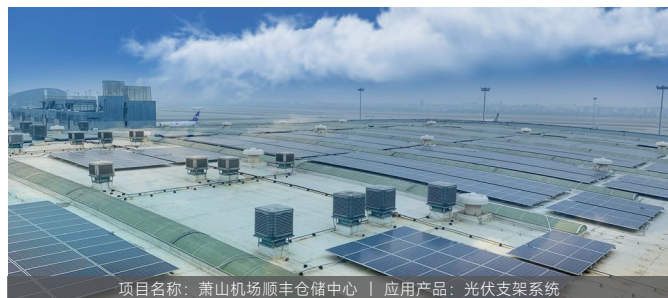
项目名称：萧山机场顺丰仓储中心 | 应用产品：光伏支架系统
