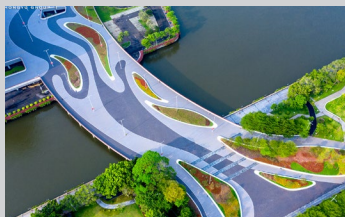
广州新中轴线慢行系统品质提升改造工程
