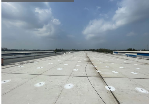
项目名称：腾讯数据中心 设计单位：中国电子工程设计院 应用产品：光伏基座
