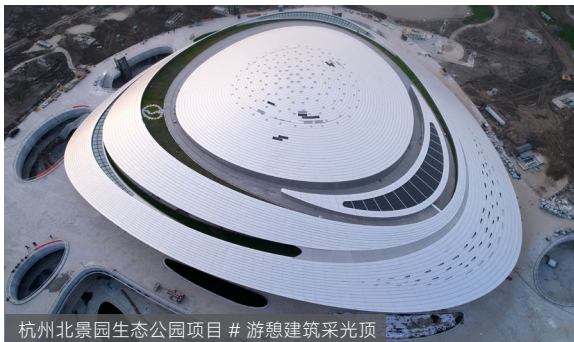
杭州北景园生态公园项目 # 游憩建筑采光顶
